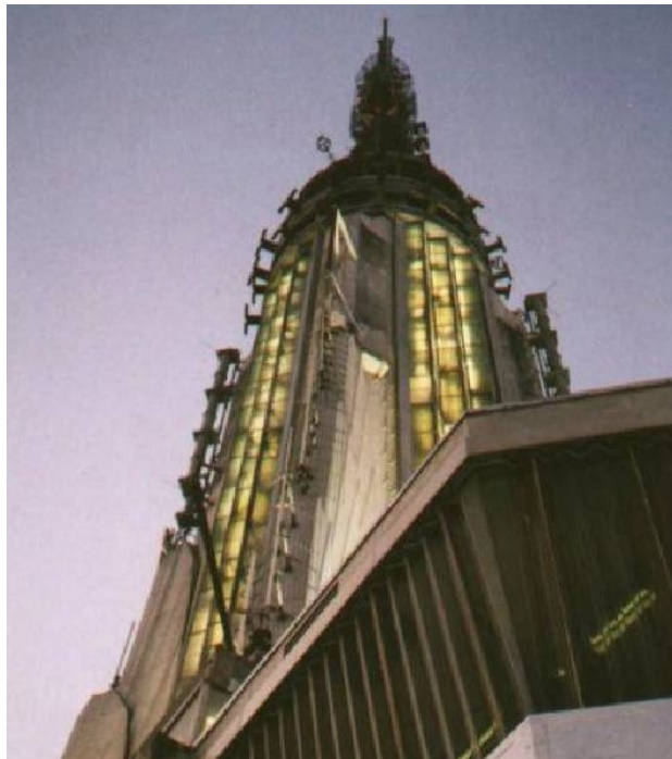
Dachkonstruktion des Empire- State- Building für King-Kong und landende Zeppeline in 380 m Höhe
