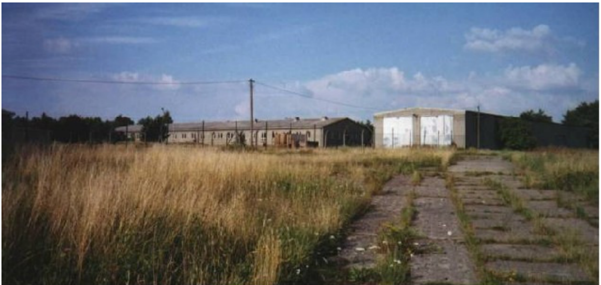
Südwest- Ansicht des Objekts; in der Halle war das Ausrüstungs- Lager, die Betonplattenstraße führte zu den SLB
